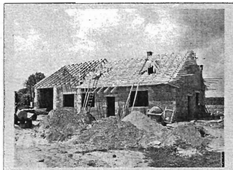
Etapy budowy remizy strażackiej w Antoniowie
