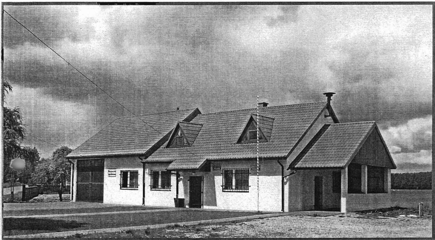
Strażnica Ochotniczej Straży Pożarnej, świetlica wiejska i biblioteka w Antoniowie
