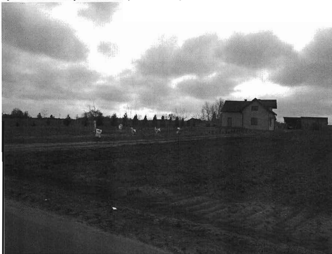
Ryc. 8 Widok na budynek mieszkalny zlokalizowany na terenie działki nr ewid. 337
